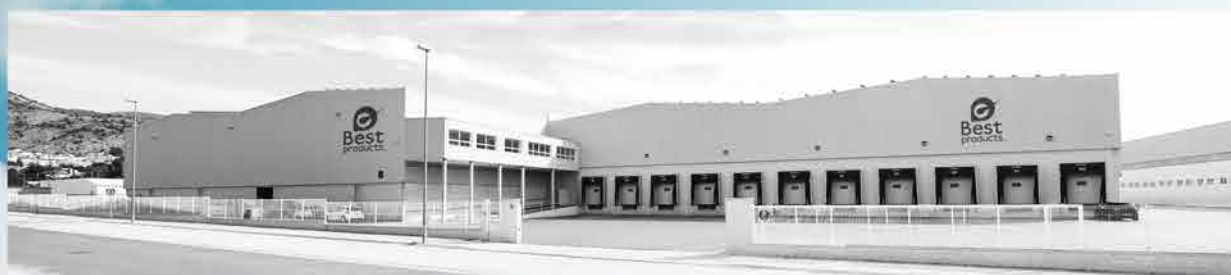
ALMACÉN PRINCIPAL Avda. de la Industria, 7 - 03430 ONIL (Alicante)
